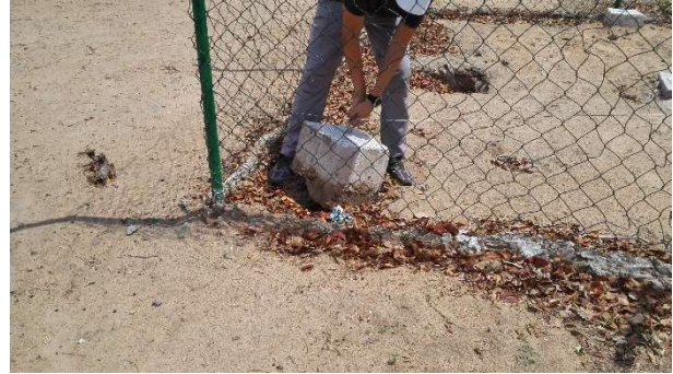
Dados de concreto mal fabricados (Namacumde)
