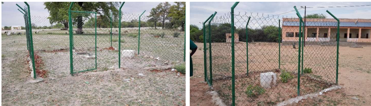
Exemplos de obras civis de uma estação agroclimática (esquerda) e udométrica (direita)
