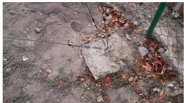
Ancoragem incorreta (esquerda) e ancoragem correta (direita)
