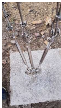
Ancoragem incorreta (esquerda) e ancoragem correta (direita)
